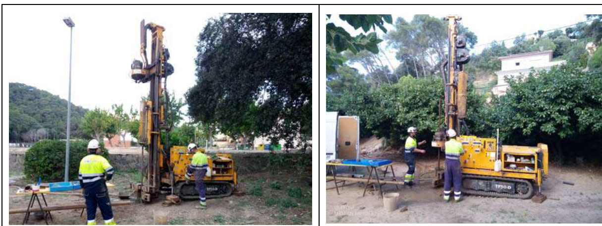
Sonda Tecoinsa TP-50 D emprada per realitzar els treballs de camp
