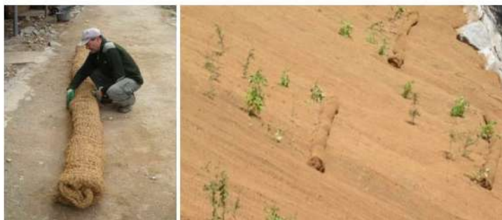
Figura 63. Detalls dels rolls de control de l'escorrentiu (cilindres de fibra natural). Font: Naturalea.
