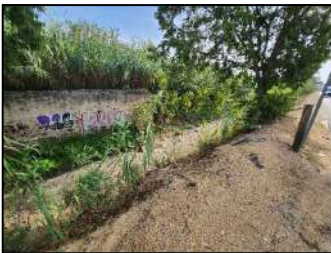
Vista del mur de mamposteria
