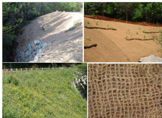
Figura 62. Exemple de talús protegit amb malla de coco i rolls pel control de l'escorrentiu (Parc del Montseny). Font: Naturalea.
