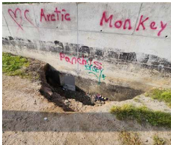
Foto 17. Estat actual del marge esquerre en el qual es pot comprovar una deficiència del drenatge del vial i la creació d'excavacions puntual a mode d'embornal per tal d'evacuar les aigües superficials del vial cap a la llera de la riera de Santa Susanna.
