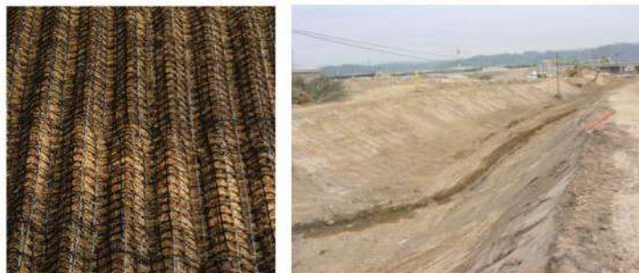
Figura 64. Geomalla c350V per a protecció del talús contra els fenòmens erosius
