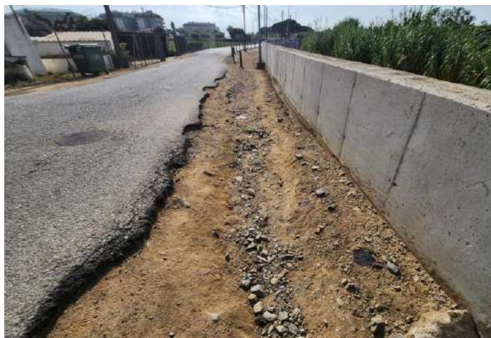
Foto 17. Estat actual del marge esquerre en el qual es pot comprovar una deficiència del drenatge del vial i la creació d'excavacions puntual a mode d'embornal per tal d'evacuar les aigües superficials del vial cap a la llera de la riera de Santa Susanna.
