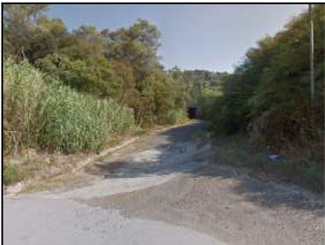
Camí a rehabilitar
