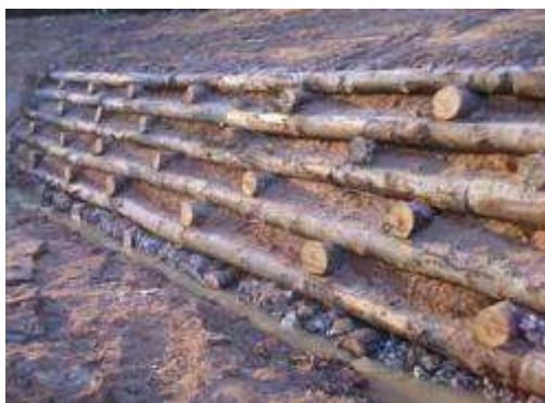
Figura 58. Exemple d'entramat Krainer tipus Naturalea o similar
