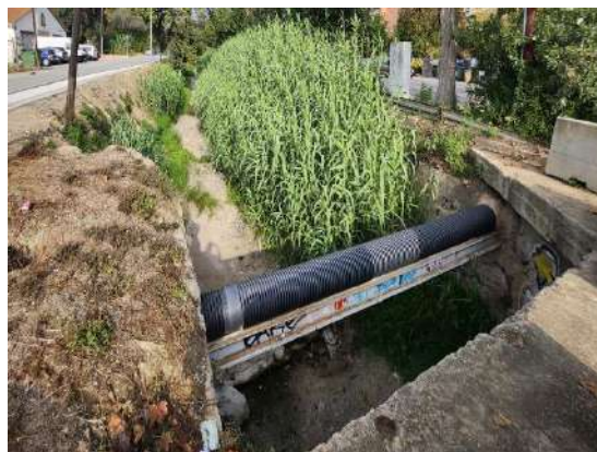
Foto 19. Pas del c. Farigola pel qual creua la xarxa unitària DN500 del clavegueram municipal.
