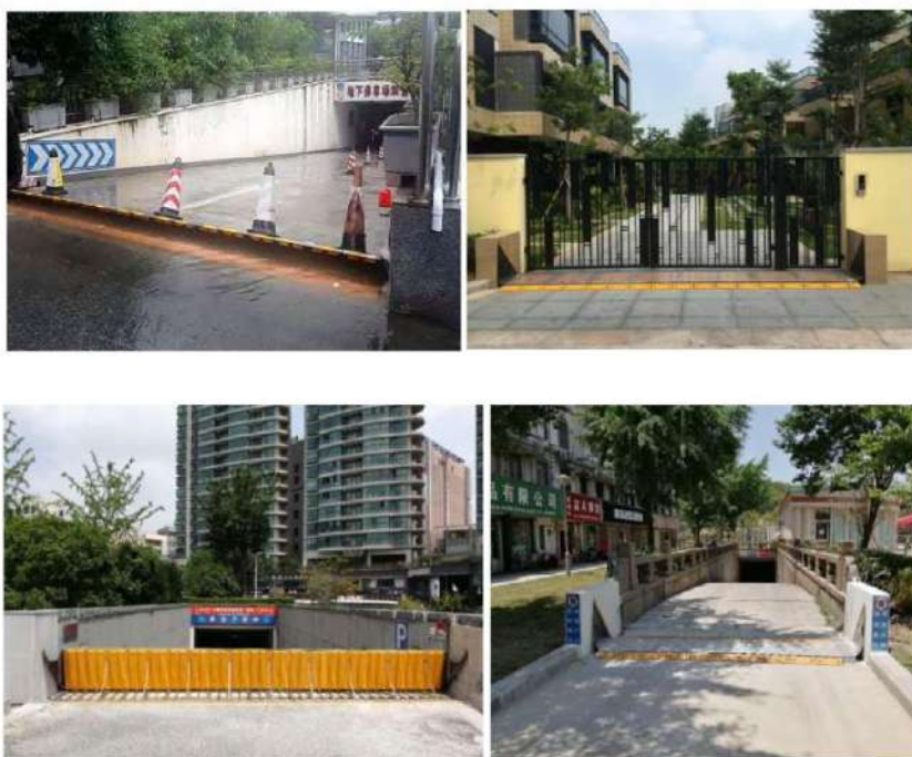
Figura 99. Solució de Lakeside de barrera prèviament instal·lada que permet una posició baixada per temps sec i una posició de barrera en cas d'inundació. El sistema s'activa mecànicament pel nivell de l'aigua.
