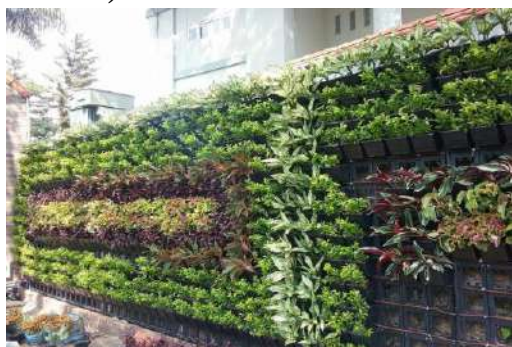
Foto 27. Sistema de mur vertical tipus Naturspot® o similar, amb mínim manteniment i sistema de reg integrat
