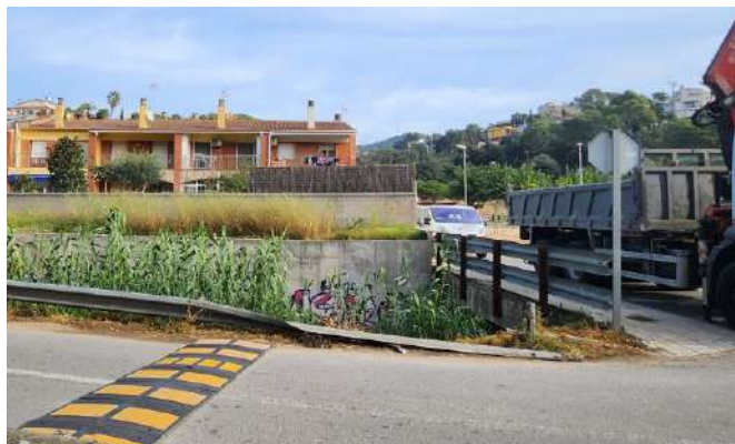
Foto 3. Vista del marge esquerre des del marge dret arribant a l'obra de fabrica existent. L'entrada a l'obra de fàbrica es materialitza amb murs de formigó armat verticals.
