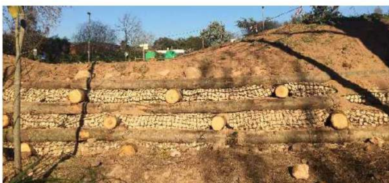
Figura 59. Entramat Krainer amb gabions tubulars tipus Rock Roll. Font: Naturalae
